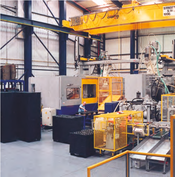
Spritzgießen in Vollautomation
